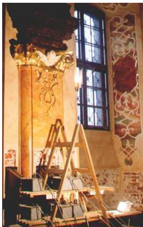
Сушка стен залы консерватории после паводка 1997 г. (г. Вроцлав)
