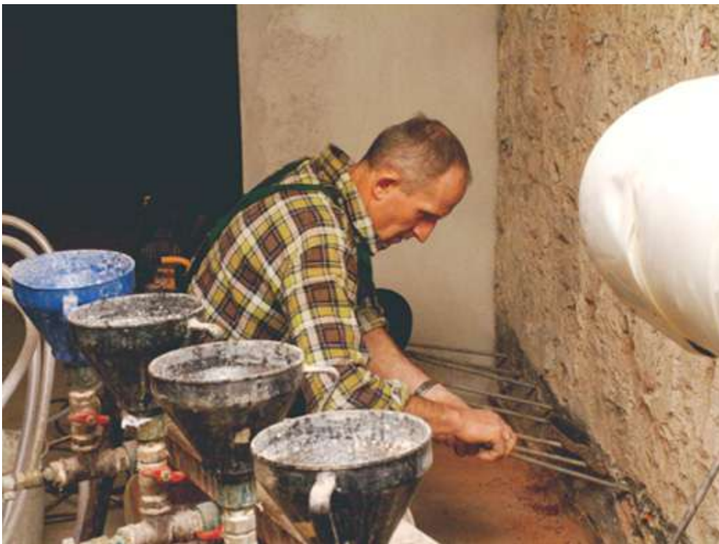
Закачивание в отверстия высушенной стены гидрофобного раствора
