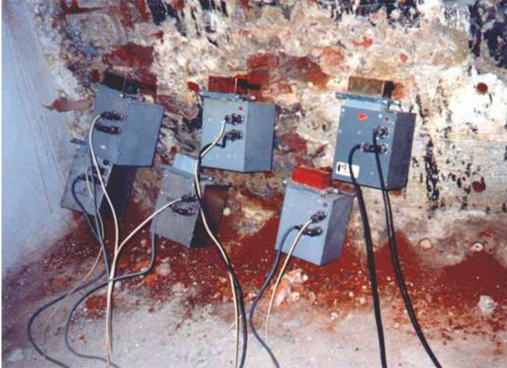
Микроволновое осушение стены с применением штырьковых антенн
