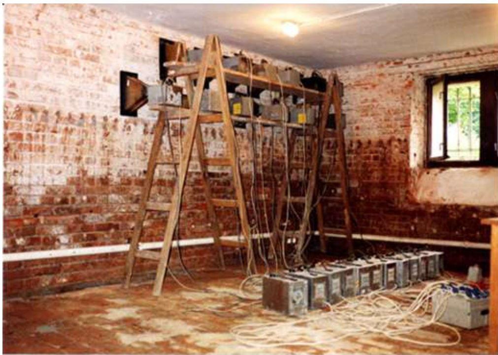
Микроволновое осушение стены с применением трубчатых антенн
