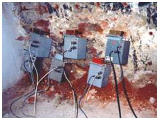
Осушение стены с помощью штырьковых антенн
