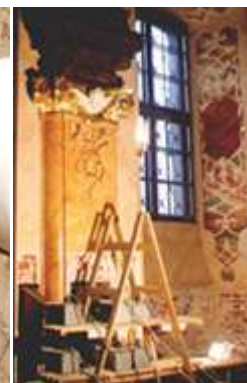
Осушение стен после паводка Вроцлав 1997 г.
