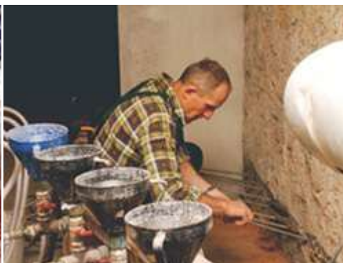
Насыщение гидрофобным раствором стены
