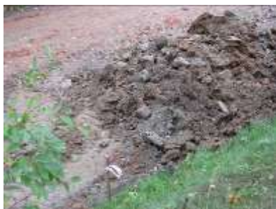
1 Грунт до стабилизации
