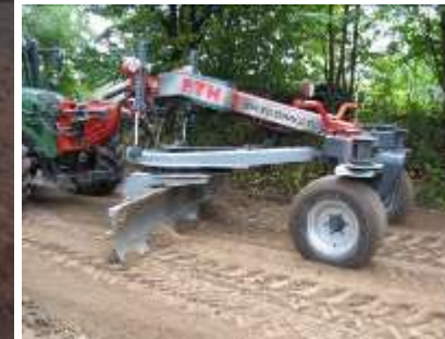
9 формирование полотна дороги
