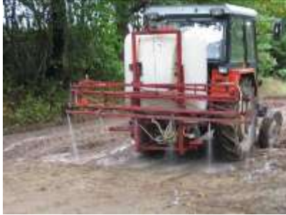
4 Полив грунта CONSOLID
