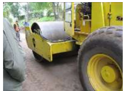
11 Уплотнение грунта катком
