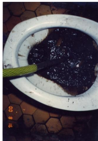
Промывка с использованием «Кинетического гидравлического тарана».
